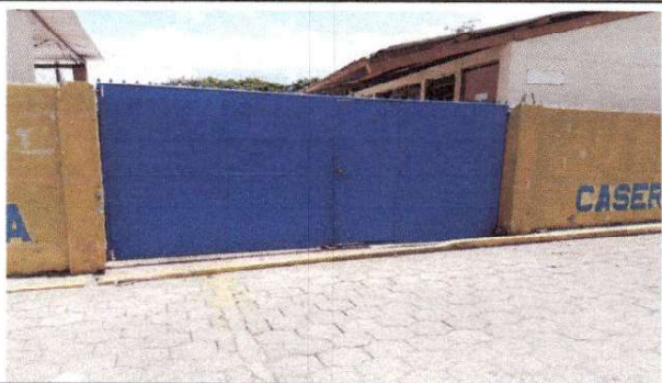
Foto 1: sustitución de porton de metal
