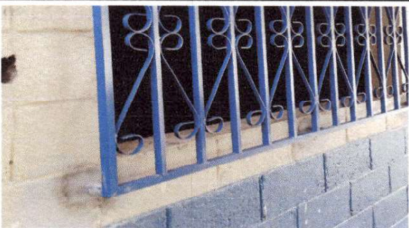
Foto 3: frabricación e instalción de ventana-balcon de metal
