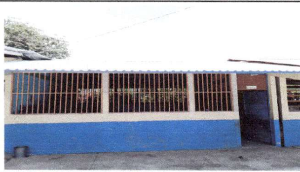
Foto 2: Sustitucion de lamina, por lamina troquelada aluzinc calibre 26
